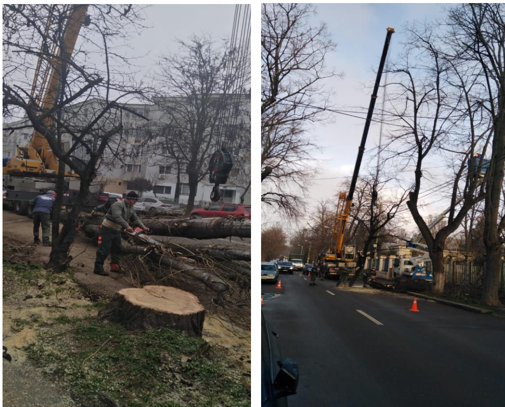
Lucrări tăieri/fasonări arbori cu utilaj PRB
