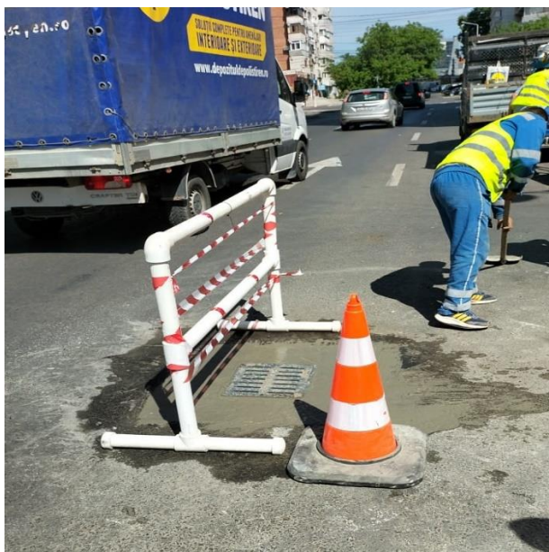
Semnalizare lucrări de înlocuire grătar gură de scurgere
